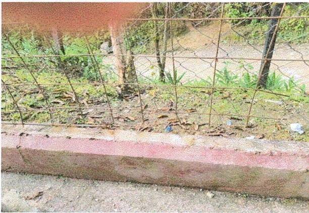
Foto 3: Modulo Muro Perimetral
