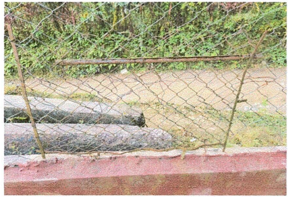
Foto 2: Modulo Muro Perimetral
